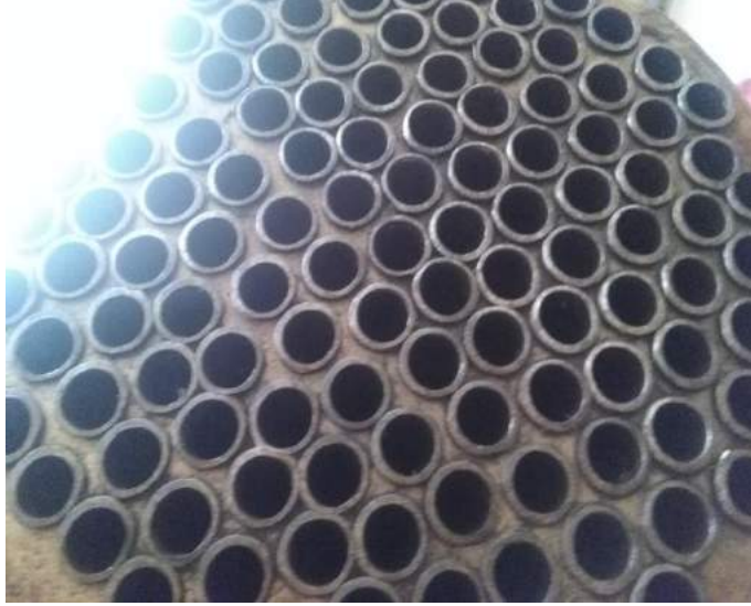
المبادل الحرارى الذي تم تصنيعه بورشة محطة كهرباء دمنهور
