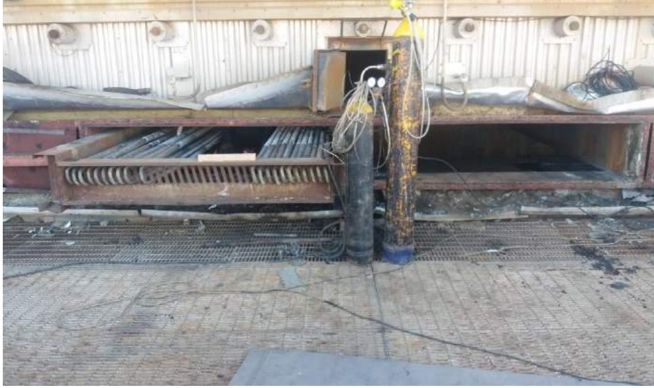
الصورة توضح Two Sectors إحداهما جاري العمل به بتركيب مواسير التبادل الحراري ( ورشة محطة كهرباء سيدى كرير )
