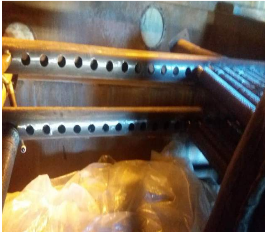
تم تصنيع Header ومواسير التبادل الحراري في ورشة محطة سيدى كرير
